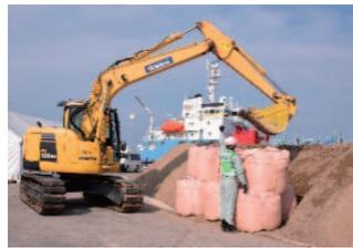
新潟県建設業協会による大型土のうでの堤防応急復旧
