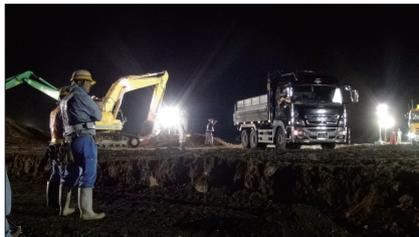
▲応急復旧状況 (H27.9.14 荒締切施工)
