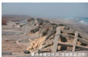
東日本被災状況（宮城県岩沼市）
