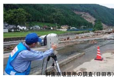
斜面崩壊箇所の調査(日田市)
