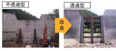
土砂・流木捕捉効果の高い透過構造の砂防施設により土砂・流木の流出を防止
