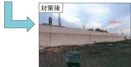
津波により倒壊した堤防を災害復旧事業による原形復旧にあわせて、災害対策推進費で嵩上げを実施しました。
