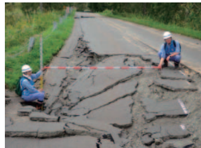
道路②班 (厚真町幌里地区)
