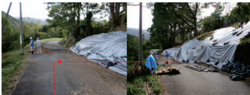
崩壊ブロック頂部上側高圧線鉄塔
