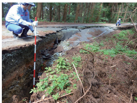
大洲市内での現地調査②（河川）
