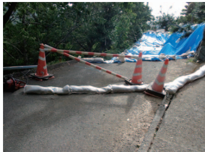
民家前の沈下箇所
