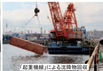
「起重機線」による沈降物回収
