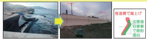
被災した護岸を災害復旧事業による原形復旧にあわせて、推進費により高上げを実施。
