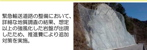
緊急輸送道路の整備において、詳細な地質調査の結果、想定以上の強風化した岩盤が出現したため、推進費により追加対策を実施。
