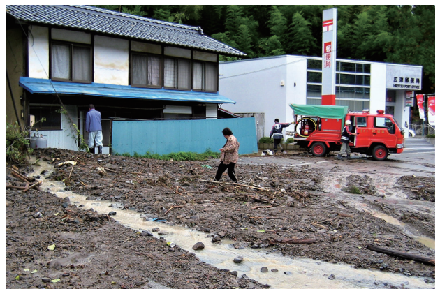
写真－10 宇留賀区の土砂流出状況
