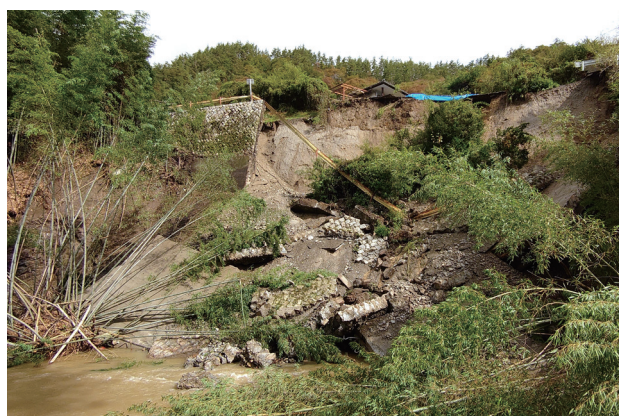
写真-18 込地集落の村道崩落の様子
