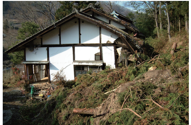
写真－8 宇留賀区の家屋崩壊状況
