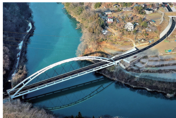
写真－13 開通した山清路バイパス（山清路大橋）
