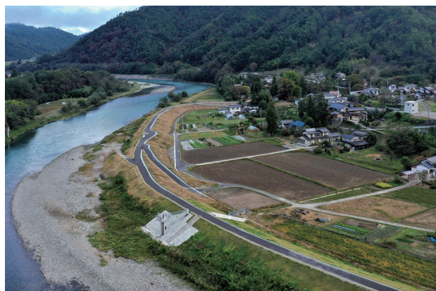
写真－12 竣工した小立野区の堤防
