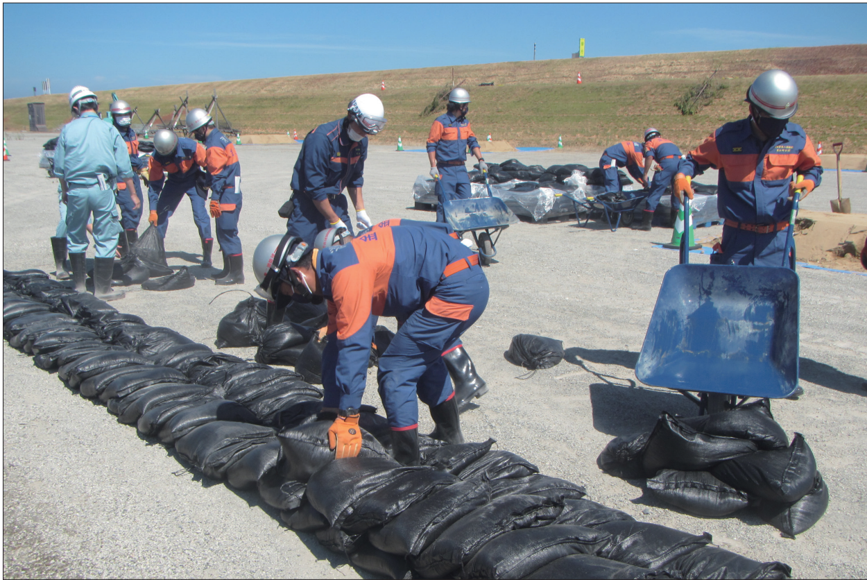
R2.8.30 令和2年度水防工法研修会（石川県川北町朝日地先、手取川右岸河川敷） 主催：手取川・梯川・石川海岸水防連絡会 （公社）全国防災協会から水防専門家を講師として派遣
