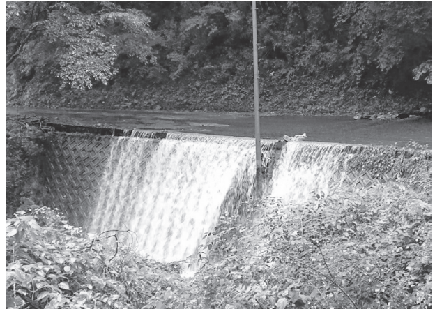
写真－2 雨水の流出状況
