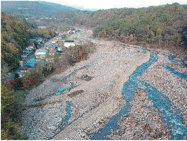
写真－5 長井川原集落の瀬替え状況
