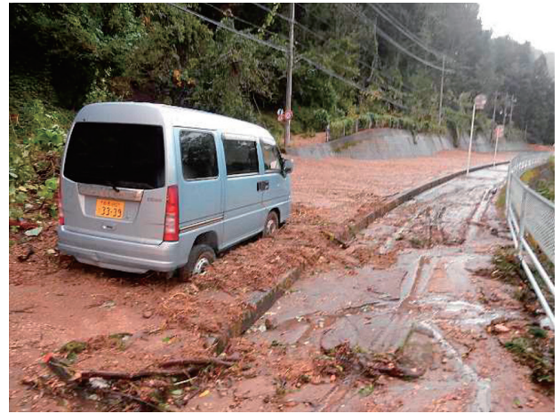
写真-4 国道144号(事業所→村役場間)の土砂流出
