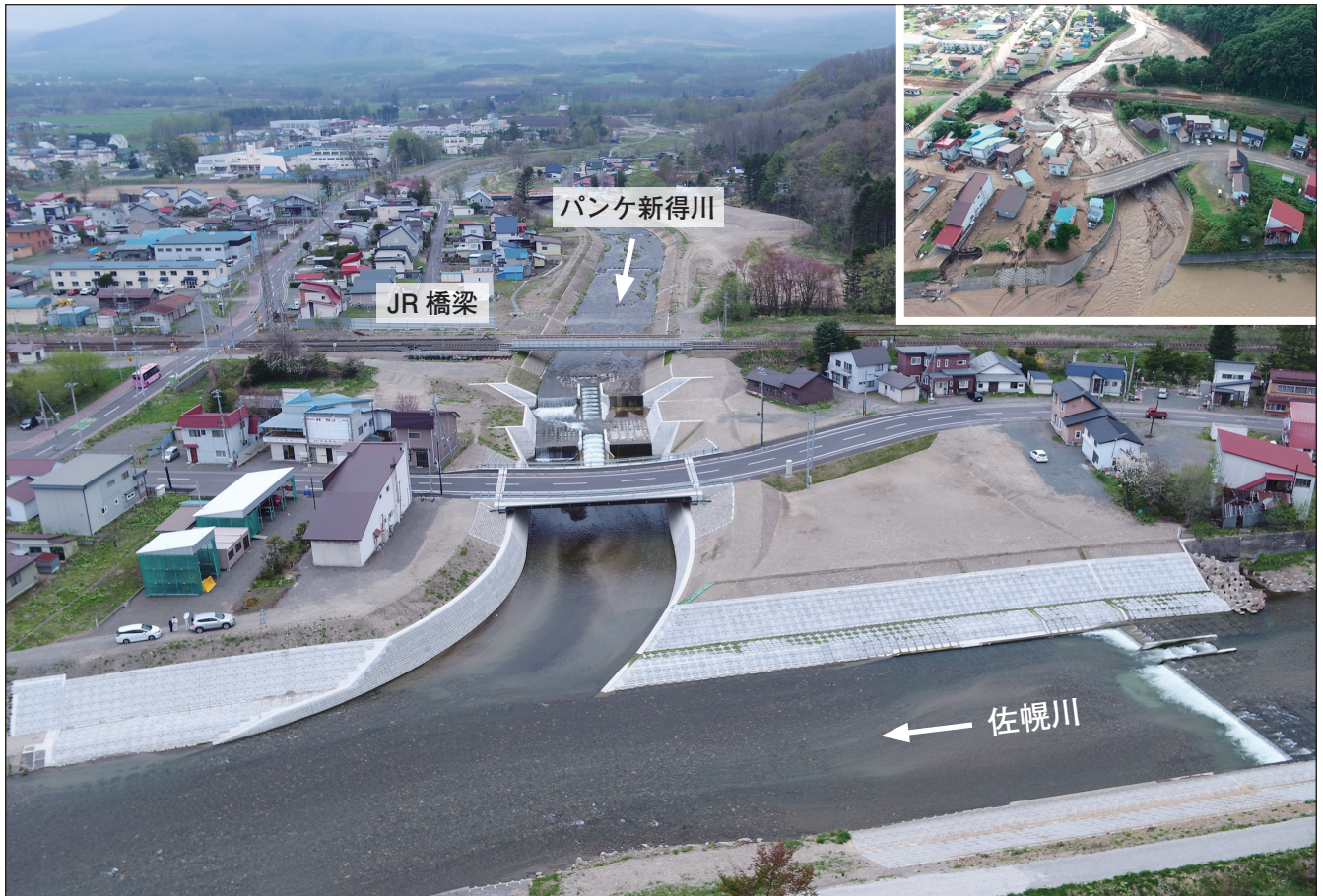
平成28年台風10号による豪雨により被災したパンケ新得川で河川災害復旧助成事業が令和3年1月に完了しました。 (写真提供：北海道、平成28年発生災害採択事例集掲載事業)
