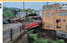
【逢初橋付近の土石流被害】 (静岡県提供)
