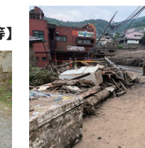
【街中の土石流被害】
