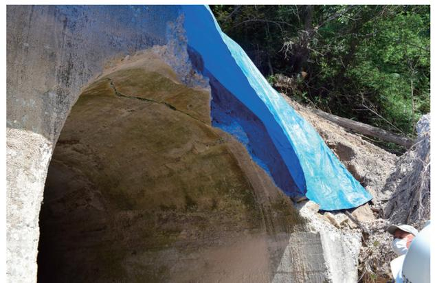
トンネル坑口崩壊及びトンネル欠落状況
