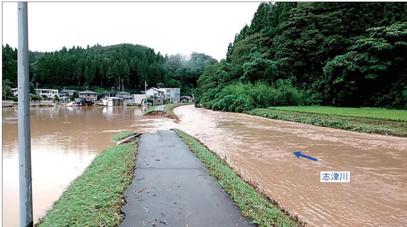
R3.7.29 九頭竜川水系志津川の左岸堤防が決壊、家屋浸水被害発生（福井市大森町）
