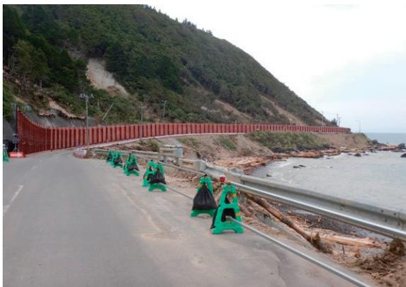
写真-14 国道279号仮設防護柵設置完了
