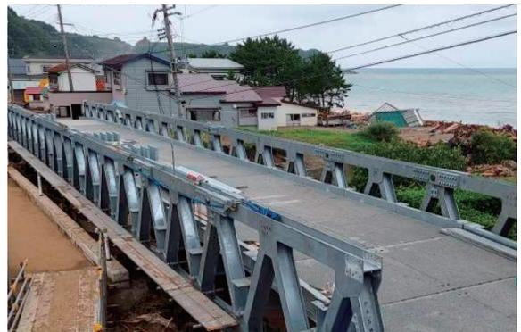
写真-12 国土交通省による応急組立橋設置完了
