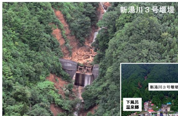
写真-16 流木を補足した砂防堰堤と
