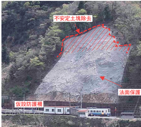
写真-3 応急対策完了
