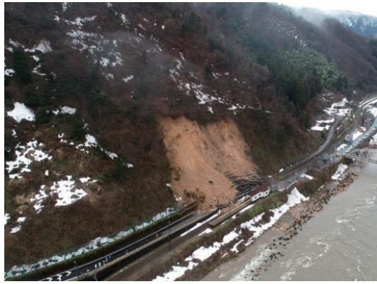
写真-1 被害全景
