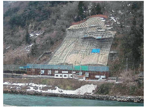
写真-4 施工状況 (令和4年3月17日時点)
