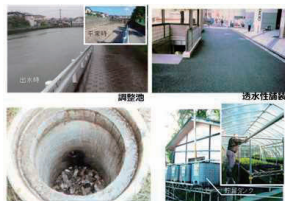
雨水貯留浸透施設の例
