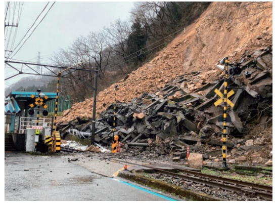
写真-2 えちぜん鉄道 小舟渡駅付近
