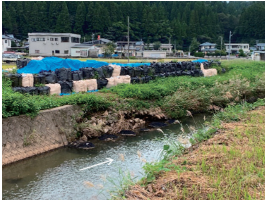
写真－5 破堤箇所の応急対策完了
