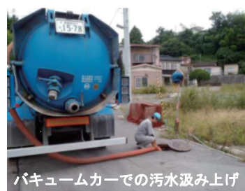
写真-3 汚水仮運搬
