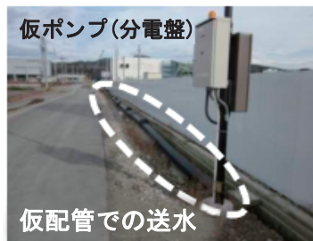
写真-2 仮排水施設（仮配管等）
