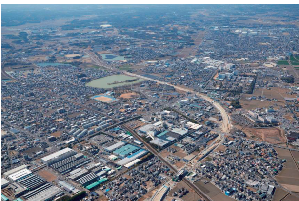
写真－1 整備が進む国道23号中勢バイパス
