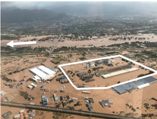
写真－1 堤防決壊により浸水した終末処理場
