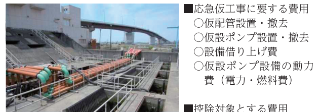
写真-3 雨水ポンプ場応急仮排水
