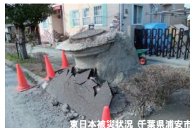
東日本被災状況 千葉県浦安市
