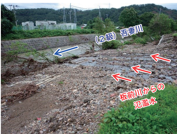
板前川からの氾濫水による護岸倒壊状況
