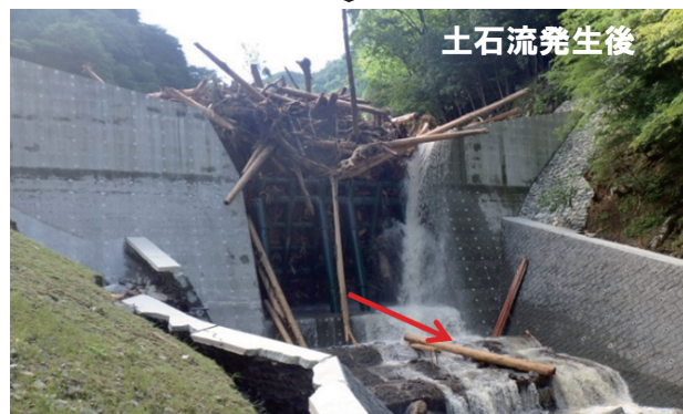
写真－1 堰堤の土砂・流木の捕捉状況
