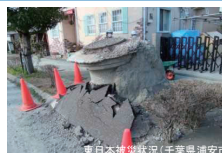
東日本被災状況(千葉県浦安市)
