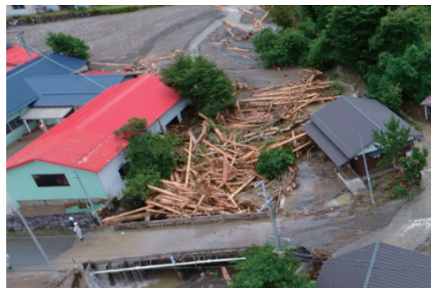
写真-3 下流域に流出した土砂・流木
