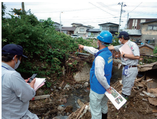
隣接箇所被災状況
