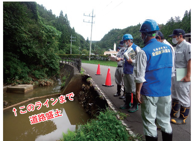
中沢川⑧ 被災及び現地説明状況
