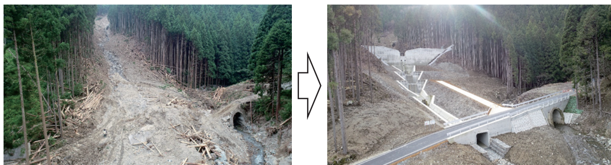
写真－5 上流堰堤と国道の復旧状況
