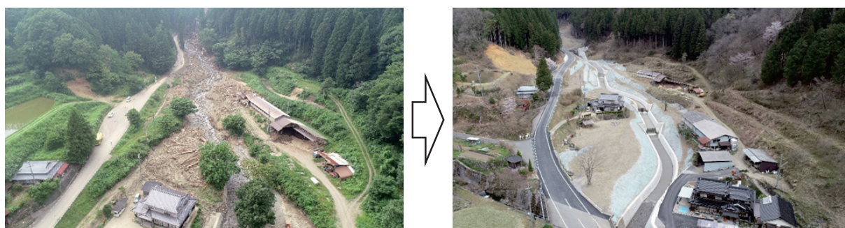
写真－7 溪流保全工の復旧状況
