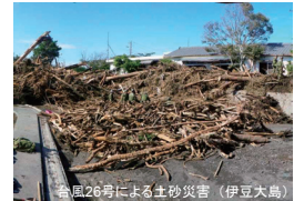
台風26号による土砂災害(伊豆大島)
