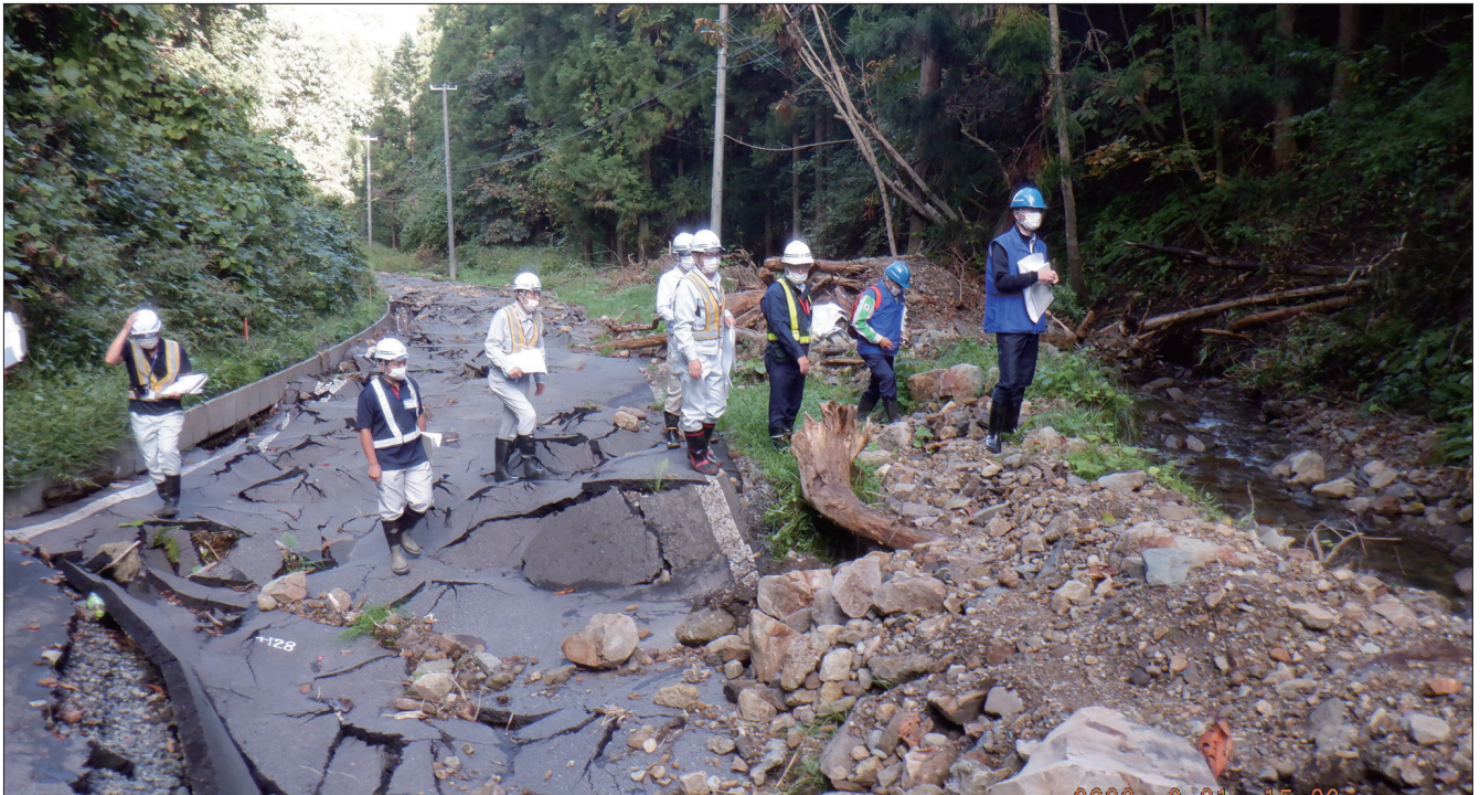
災害復旧技術専門家派遣（岩手県一戸町）令和4年8月豪雨により被災した町道の復旧支援
