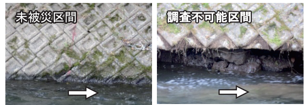
写真-4 護岸基礎状況 (工事着手時確認)
