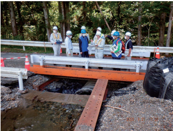
損壊した管渠上部に仮排水管設置
