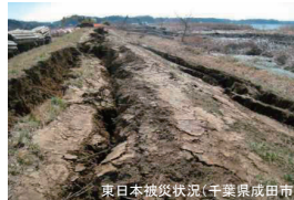
東日本被災状況(千葉県成田市)
