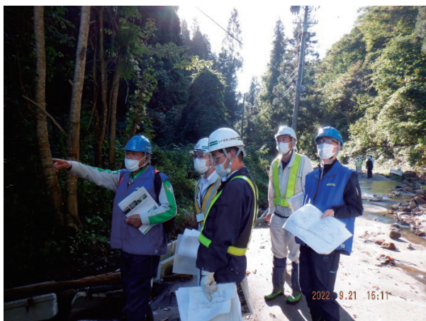
被災状況の確認
