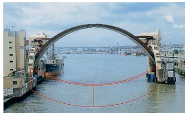
図-6 三大水門の位置図(左)とアーチ型をした安治川水門(右：赤色は水門閉鎖時を示す)
