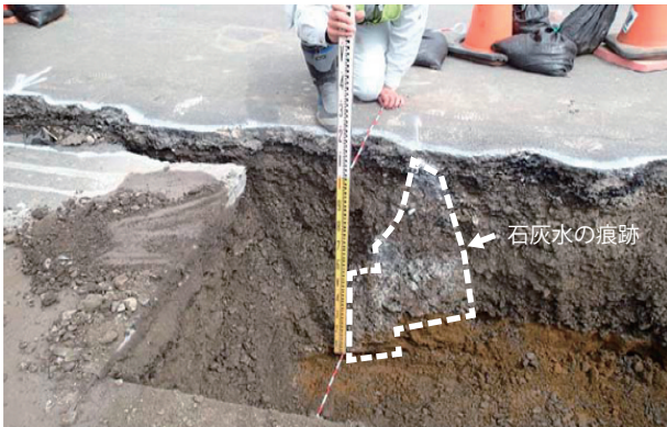
写真-3 試掘の状況
