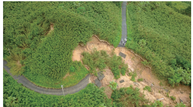
被災状況（ドローン撮影）
