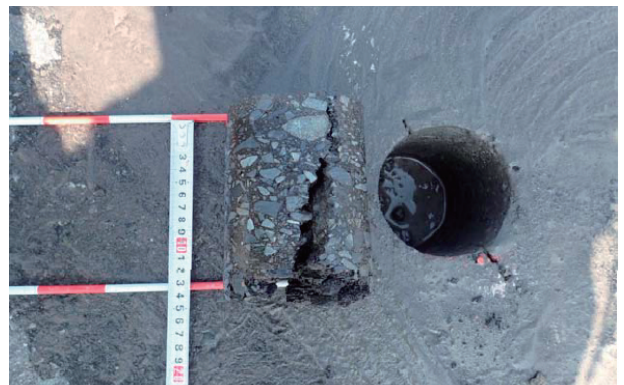
写真－2 舗装のコア採取
