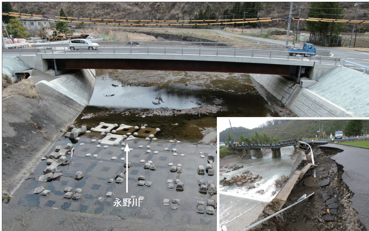
令和元年台風19号により被災した「久保田橋橋梁災害関連事業」が令和4年1月完了 一橋梁の単径間化により再度災害を発生させない橋梁への改良復旧— (写真提供：栃木県、平成31年・令和元年発生災害採択事例集掲載事業)
