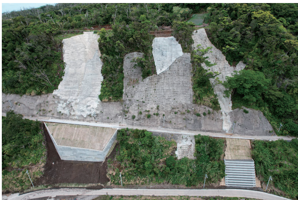
被災状況（完成）
