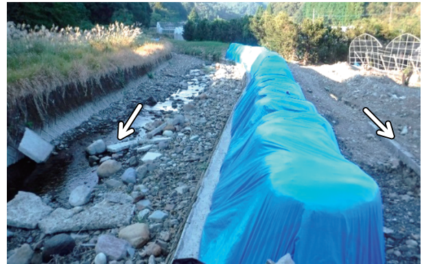
写真-4 河川工事の増破対策事例
