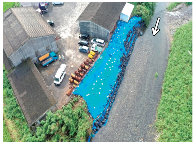
写真-5 応急工事の増破対策事例
