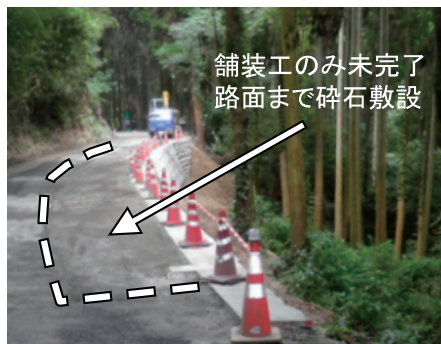
写真-2 前災工事中
