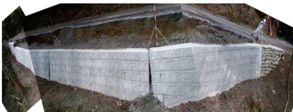
写真-3 増破状況
