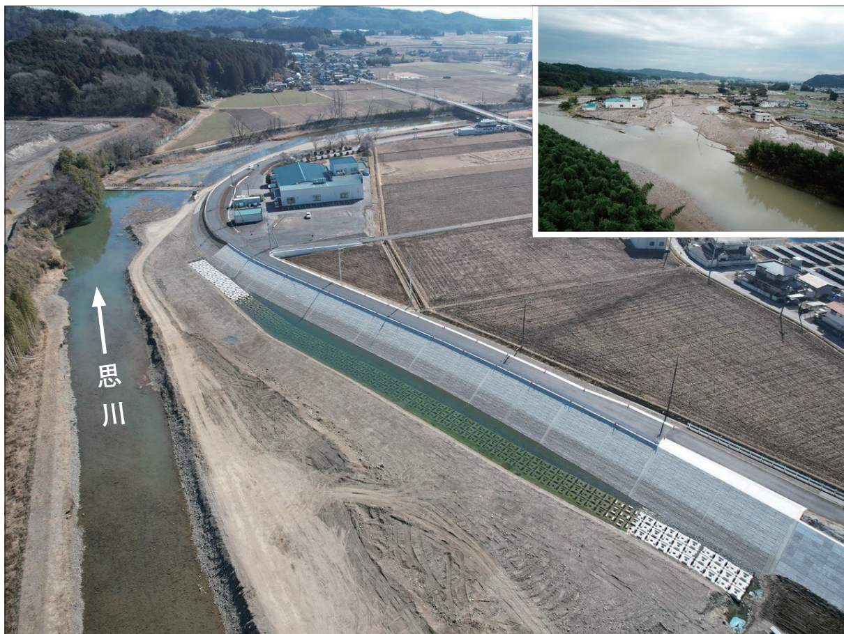
令和元年東日本台風により被災した思川で災害復旧助成事業が令和5年2月完了 (写真は天満橋下流工区、写真提供：栃木県)
