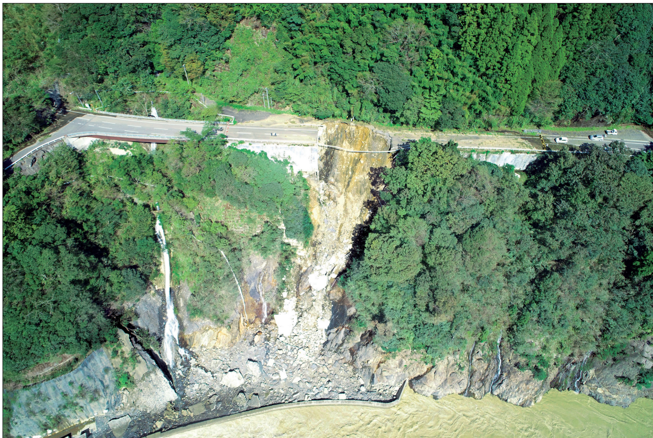
宮崎県一般国道327号、令和4年9月台風14号により道路崩壊（諸塚村松の平地区） 写真提供：宮崎県
