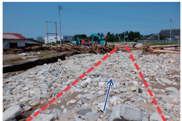
写真－5 河道埋塞状況（平野部）
