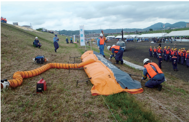
水防工法訓練（越水止め水のう工） （令和5年度 大和川水防・大阪府地域防災総合演習）
