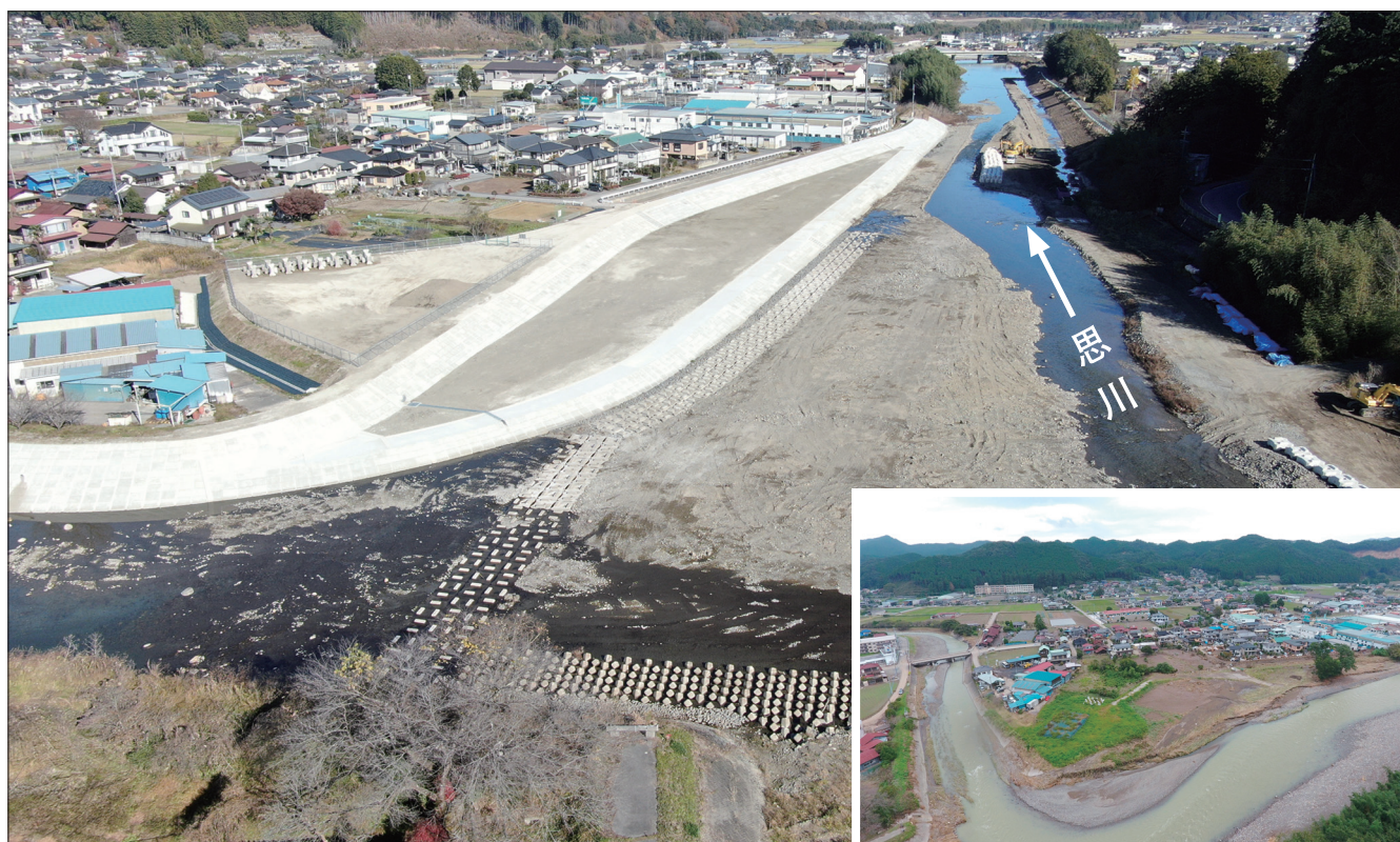
令和元年東日本台風により被災した思川で災害復旧助成事業が令和5年2月完了 (写真は栗野川合流下流工区、写真提供：栃木県)
