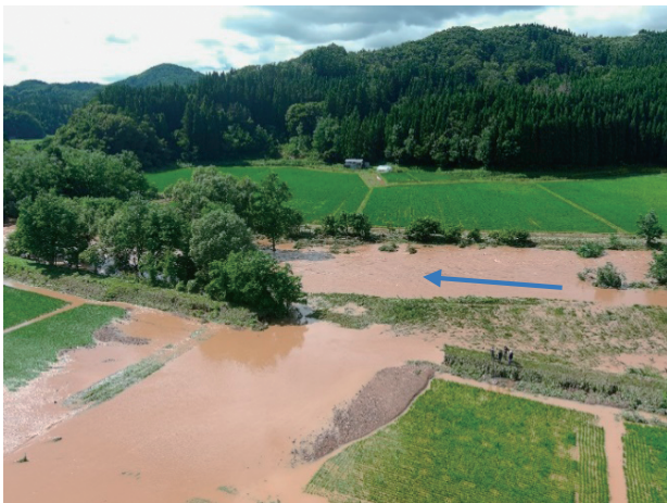
写真-1 一級河川 下内川 破堤箇所
