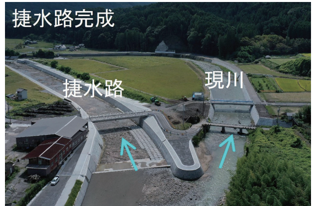
図-9 大肥川 捷水路全景
