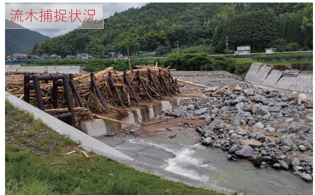
図-11 小野川 流木捕捉状況
