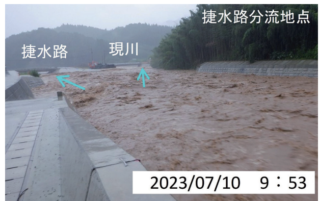
図-10 大肥川 捷水路出水状況
