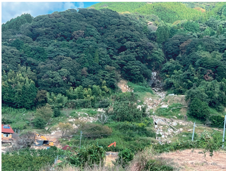
唐津市浜玉町今坂地区の土石流災害被災現地
