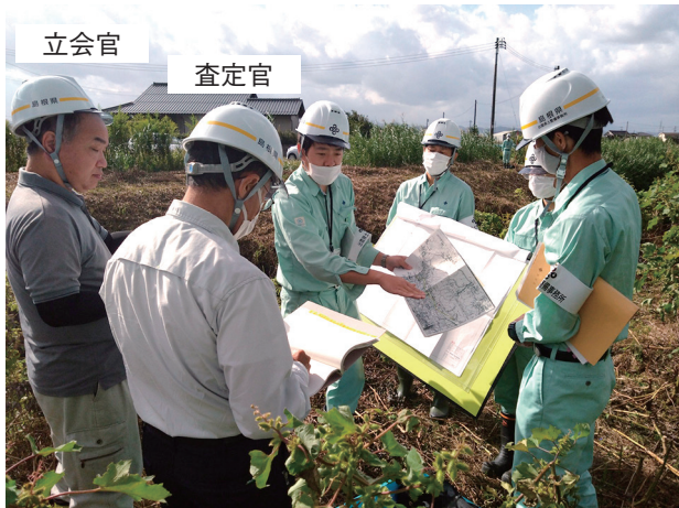
写真-1 通常査定時三者手持ち状況 (実地査定)
