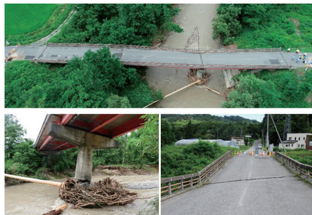
写真-3 上屋敷橋（米沢市）
