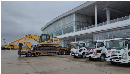
積み込みを待つ緊急復旧用重機（14台）
