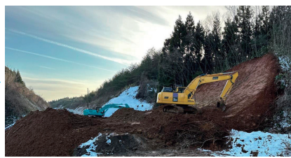
復旧作業状況【1/14撮影】
