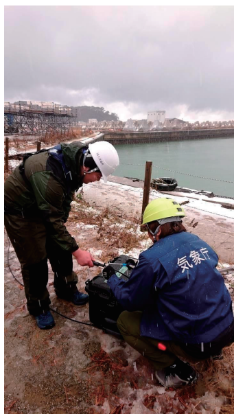
①組立作業の様子
