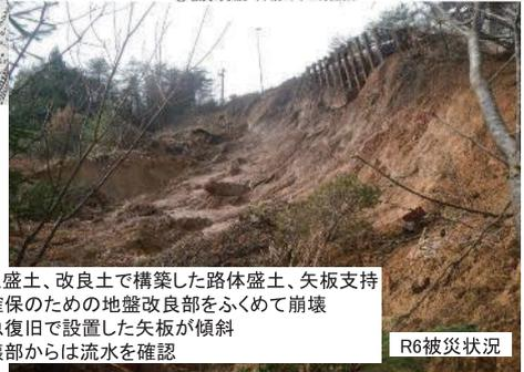
抑え盛土、改良土で構築した路体盛土、矢板支持力確保のための地盤改良部をふくめて崩壊
