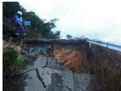
R6被災状況:地すべりによる段差亀裂
