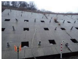
R6被災状況:グラウンドアンカーの破損(飛び出し)
