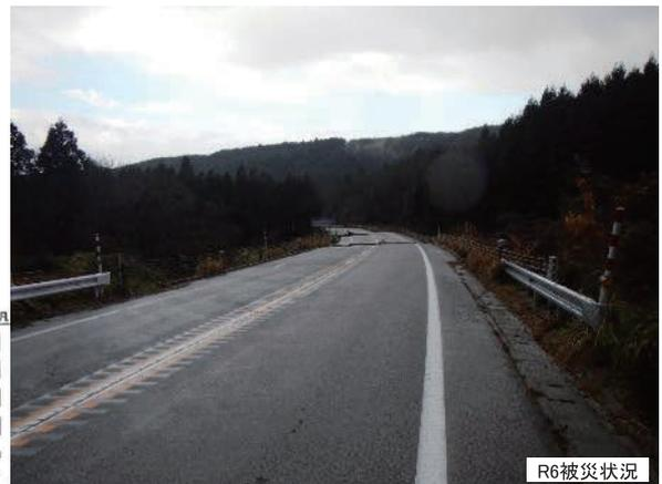
盛土高約15mの谷埋め盛土でクラック程度の被災 H19大規模崩壊箇所(縦14)で基礎地盤砕石置換え、補強盛土、抑え盛土により復旧された箇所
