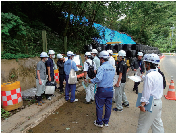
写真－6 緊急調査実施状況
