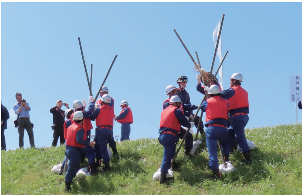
水防工法訓練（五徳縫い工） （九頭竜川水系総合水防演習）
