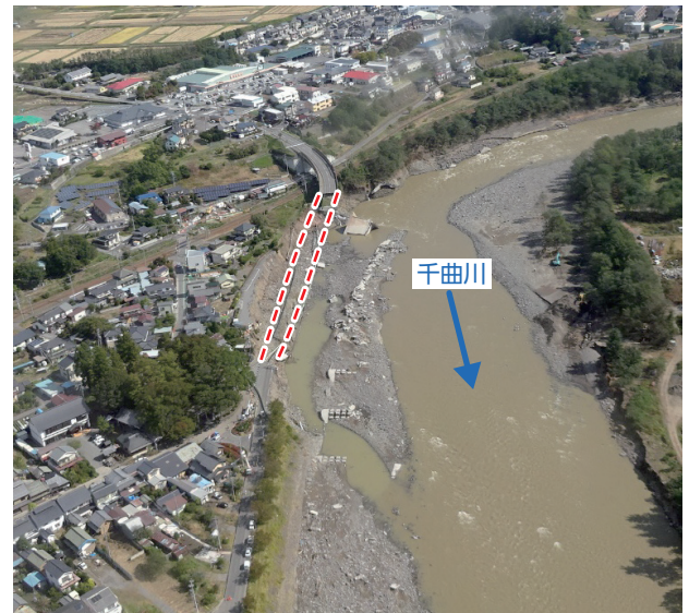
写真－1 東日本台風による橋梁の崩落 （海野宿橋：長野県東御市）
