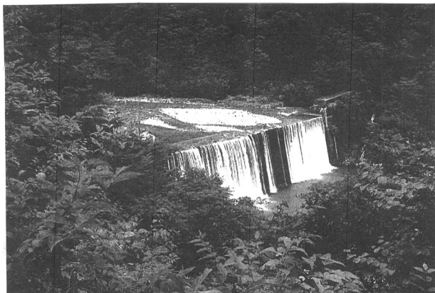
図－1 満砂状態の砂防堰堤 （飛驒の砂守、中田聡一郎より）
