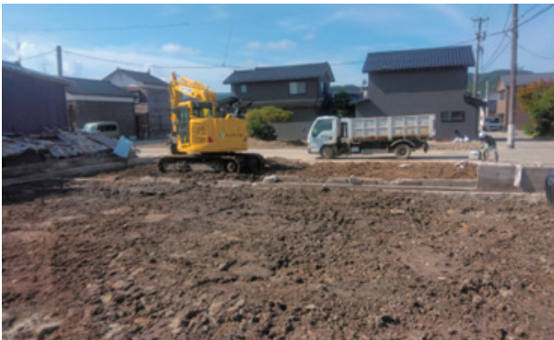
公費解体の状況（輪島市）
