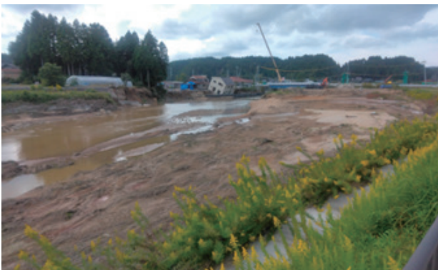
若山川の破堤箇所（珠州市）
