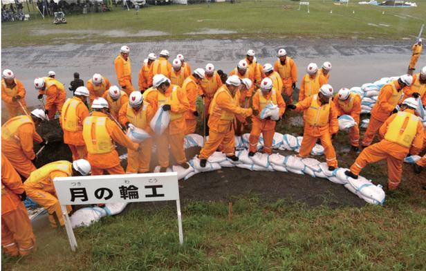
水防工法訓練（月の輪工）
