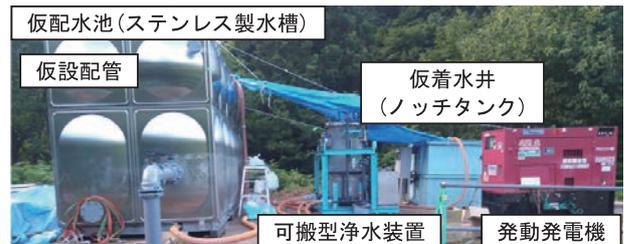
写真-3 応急仮工事（可搬型浄水装置）
