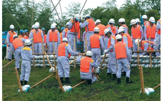
水防工法訓練（杭打ち積み土のう工）
