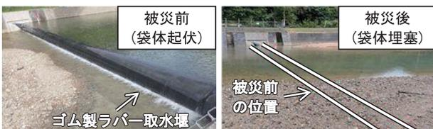
写真－7 ゴム製ラバー取水堰の埋塞状況
