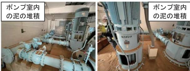
写真－5 機械設備（取水ポンプ）の浸水後の状況
