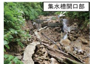
写真-2 導水管の破損
