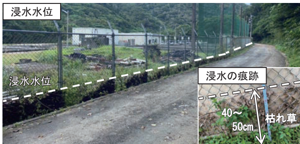
写真－2 浸水水位と浸水の痕跡
