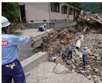
河川被害状況の調査
