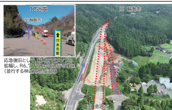
復旧状況 (本線・金沢方面オフランプの崩土撤去状況)
