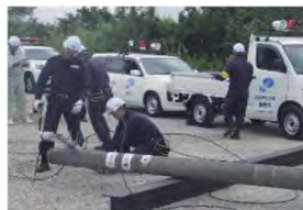
写真③ 倒壊電柱の除去訓練
