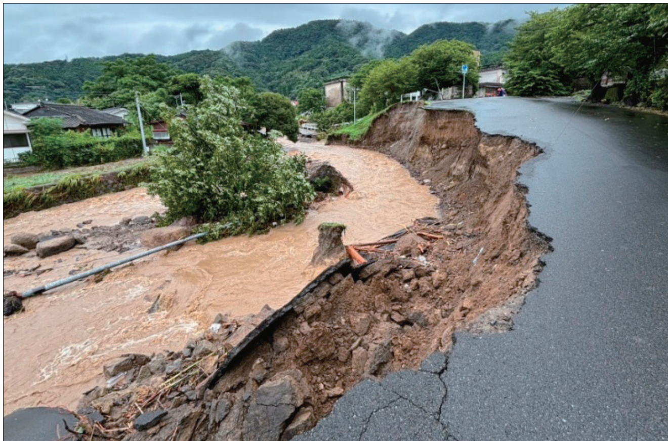
令和7年8月豪雨により湊川の河岸流出被害 写真提供：鹿児島県霧島市
