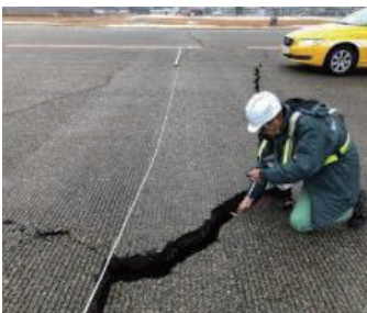
空港基本施設(滑走路等)の調査
