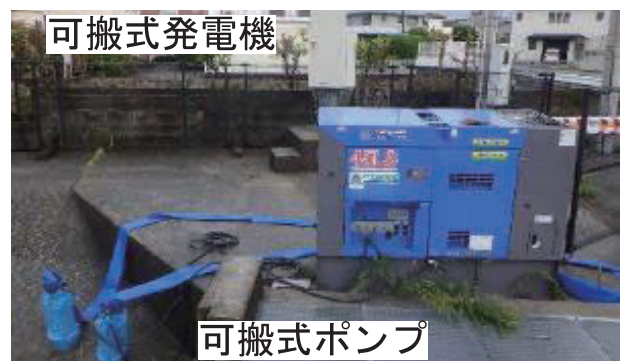
写真－3 応急仮工事の状況
