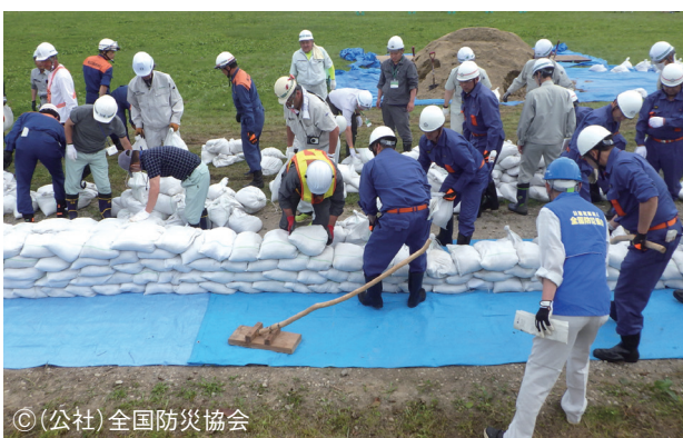
水防専門家の指導 積み土のう工(杭省略型)
