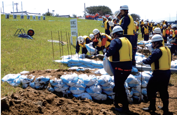
水防工法訓練(月の輪工) (最上川下流・赤川総合水防演習)
