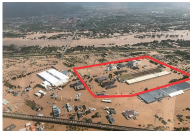
写真－8 令和元年東日本台風による処理場の被災事例
