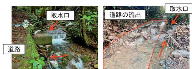
写真－3 導水管の被災前
