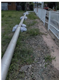
地上への仮設配管
