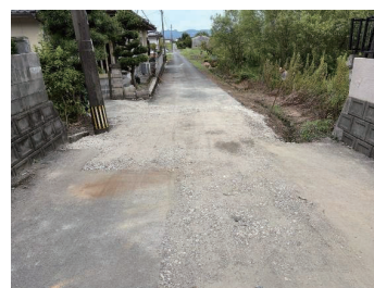
仮設配管設置後の路面状況（宇城市）
