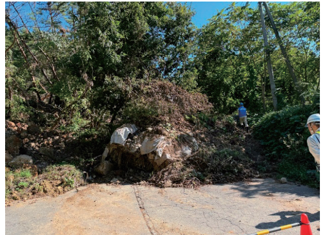
被災状況（道路全面通行止め）
