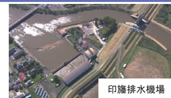
大和田排水機場
